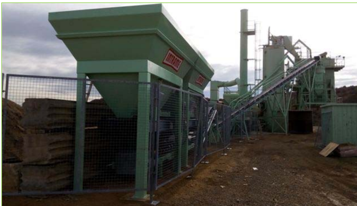
Detalle línea de fresado en planta de MBC de Cubillas
