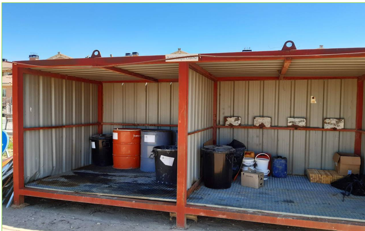
Punto Limpio Instalado en Obra
